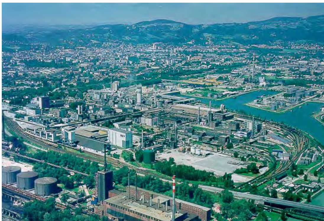
Abbildung 8.16: Überblick über den Altstandort „Chemiepark Linz“ (von Südosten) – im Vordergrund die Kokerei der voestalpine Stahl GmbH; im Hintergrund die Stadt Linz und der Hafen
